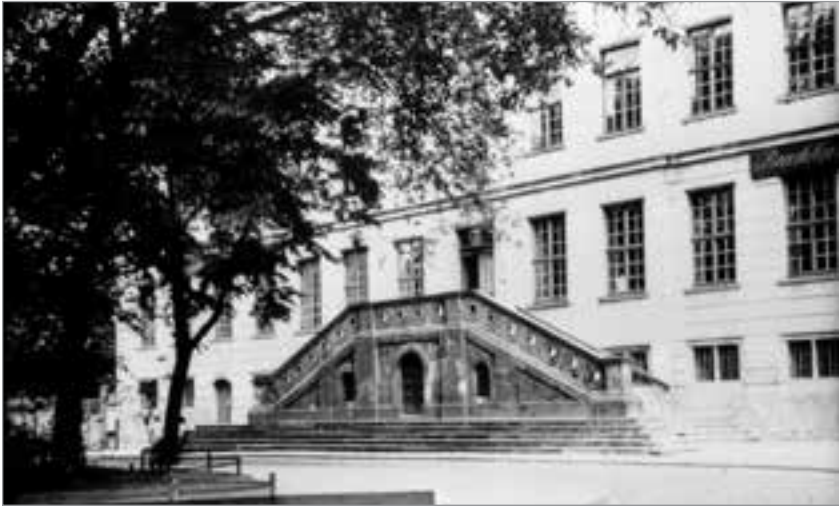
Abb. 8: Vorderansicht des Waisenhauses, Freitreppe und Erdgeschoss (linke Bildseite: Norden), 1940
